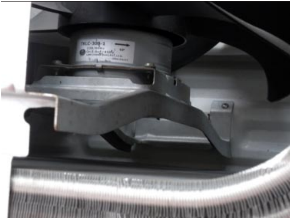
[圖一] 傳統的熱排風扇大部分是 AC 感應馬達，一開機風扇就啓動，它的作用是将壓縮機吐出時產生的熱排到大氣中
